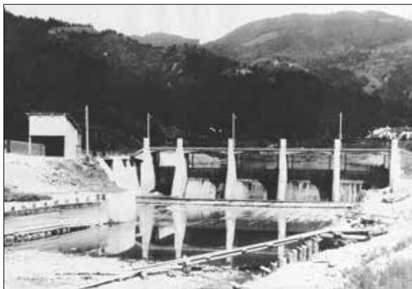
Jez hidroelektrarne Pustnik po dograditvi leta 1917
